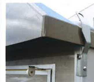
吊り金具とドアストッパー
